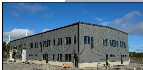
Geologibyggnad – entreprenad pågår, avslutas 2025
