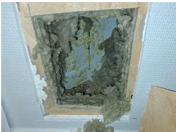
Foto 14 tillbyggd vägg öppnad
