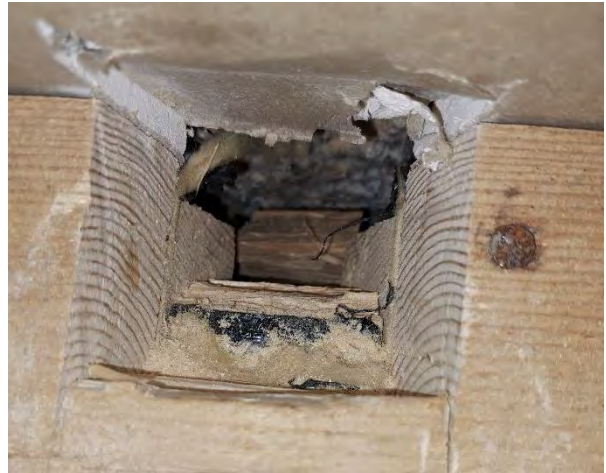
Foto 17 dubbla syllar i yttervägg
