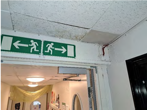
Foto 9 fuktrosor, taksläpp i passage
