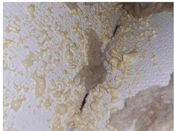
Foto 15 fogsikum sprutat i spricka i ytterväggshörn
