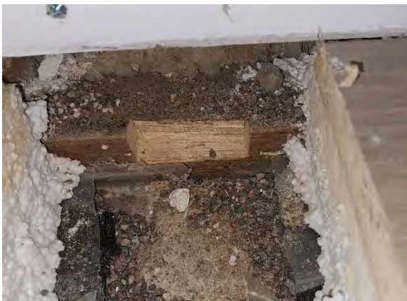
Foto 4 öppnad golvkonstruktion med cellplast, plastfolie samt sandfyllning
