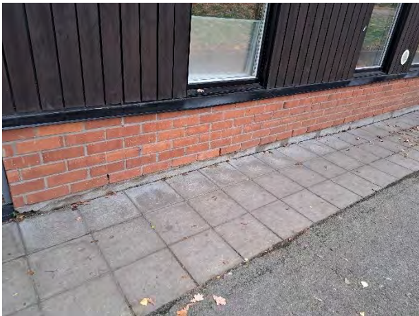
Foto 8 hög marknivå utvändigt
