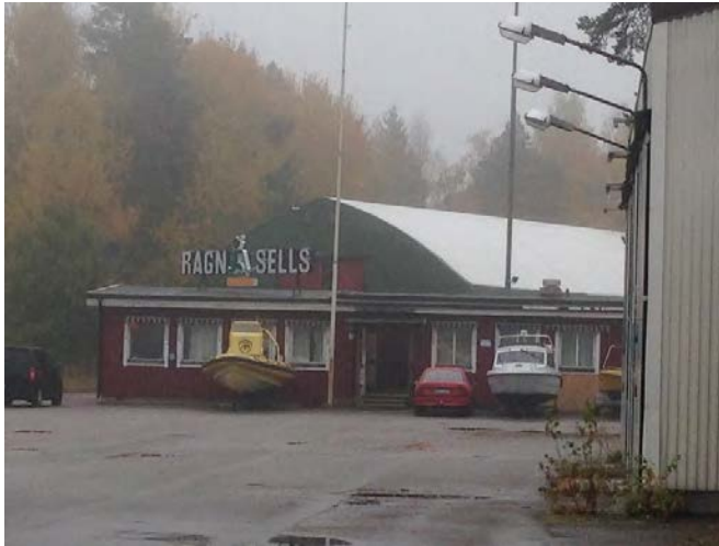
Figur 9. Södra hörnet på huvudbyggnaden med kontor.
