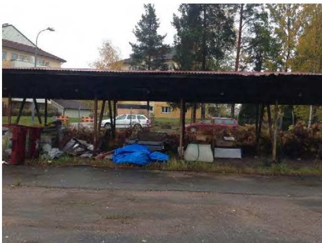
Figur 8. Skärmtak i norra delen av fastigheten för förvaring av utrustning.
