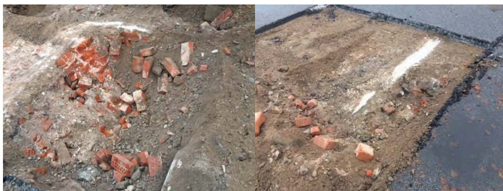
Figur 4. Rester av en äldre byggnad påträffades vid schaktning i undersökningsområdet.
