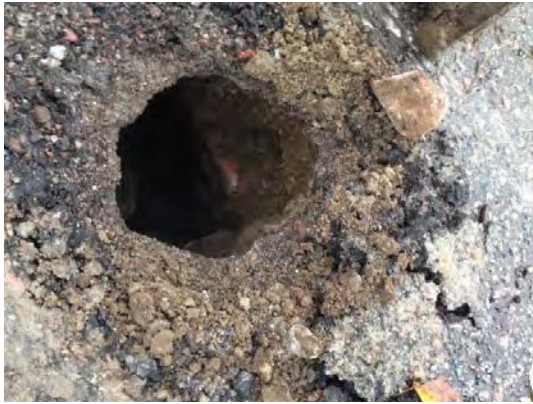
Figur 13. Tegel i marken i borrhål BH18, troligtvis rester från tidigare husgrund.
