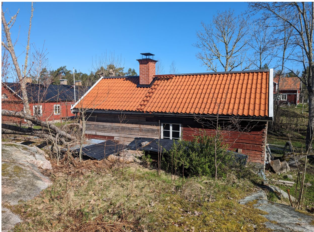
Figur 10. Baksidan på bagarstugan med en del nytt timmer i fasaden, nytt tak och skorsten. Foto från platsbesök 2024-05-10.
