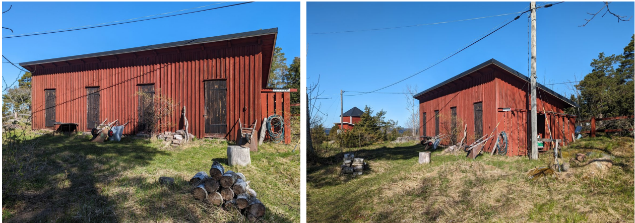
Figur 2. Den nya komplementbyggnaden på Västerbyn 4:7 planeras att uppföras i samma utformning som komplementbyggnaden på Västerbyn 3:2. Foto från platsbesök 2024-05-10.
