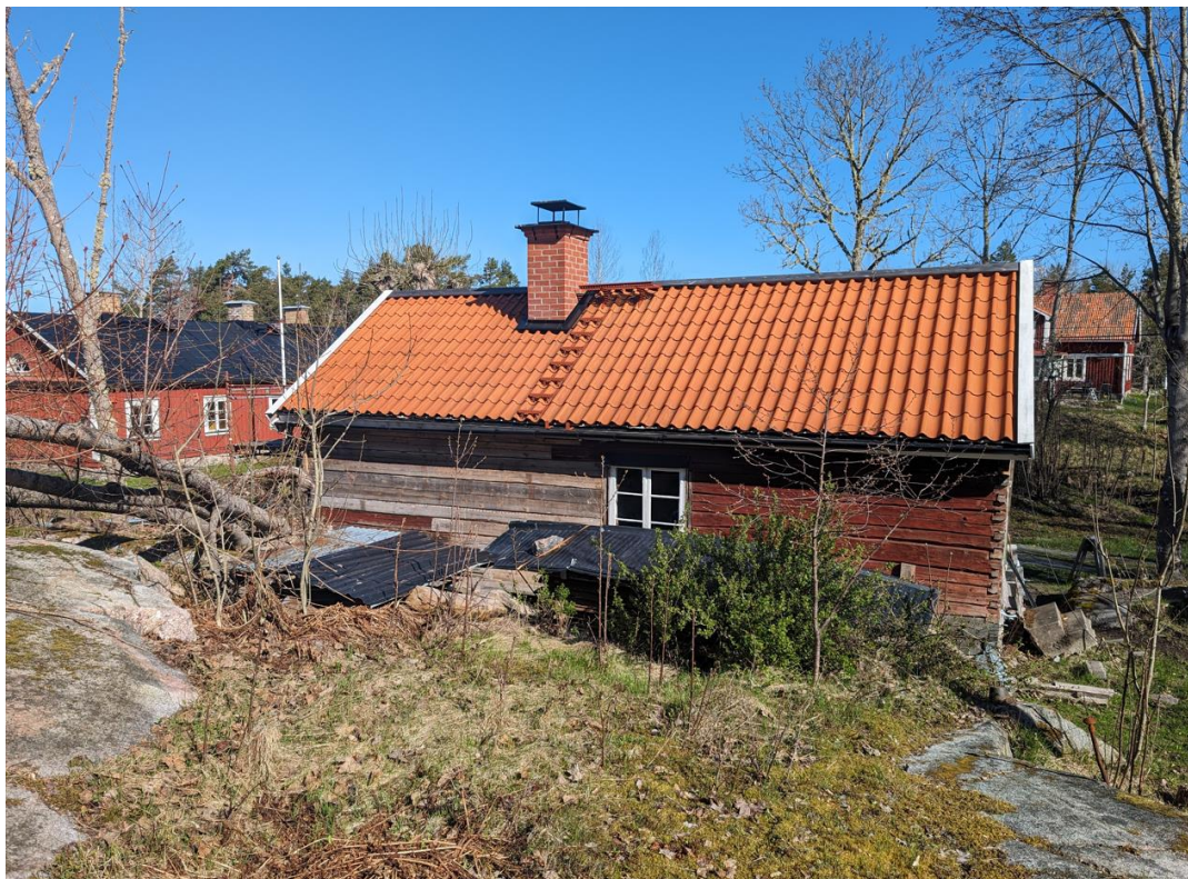
Figur 11. Baksidan på bagarstugan med en del nytt timmer i fasaden, nytt tak och skorsten. Foto från platsbesök 2024-05-10.
