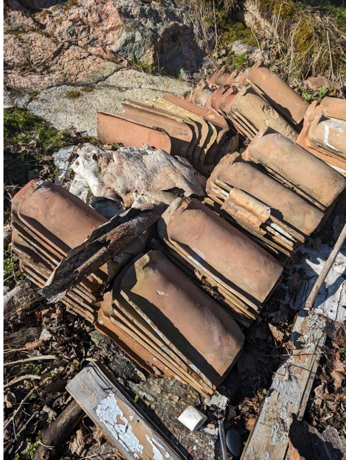
Figur 6. De äldsta tegelpannorna är märkta på undersidan med årtal och namn på tillverkaren. Foto från platsbesök 2024-05-10.
