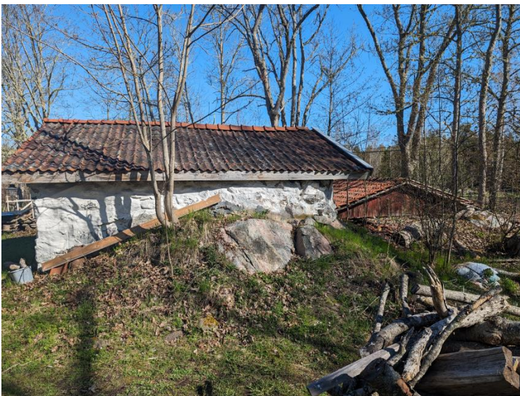
Figur 9. Längsidan av stenkällaren, jordkällarens tak syns till höger. Foto från platsbesök 2024-05-10.
