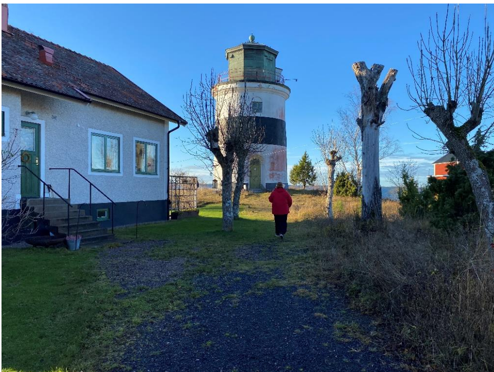
Figur 45. Foto på Djurstens fyr och fyrmästarbostad till vänster. Den allmänna vägen slutar vid Djurstens fyr. Foto från platsbesök 2024-11-12.
